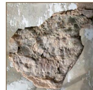
Décollement de l'enduit sur un mur de moellons
