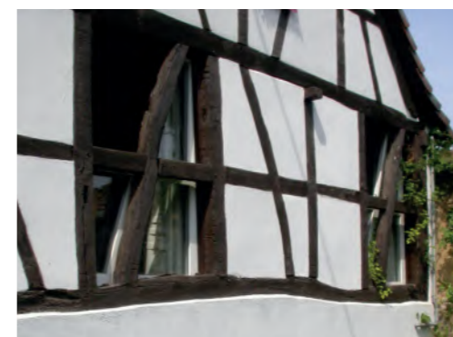
Mise en place d'un vitrage à l'arrière du colombage.
