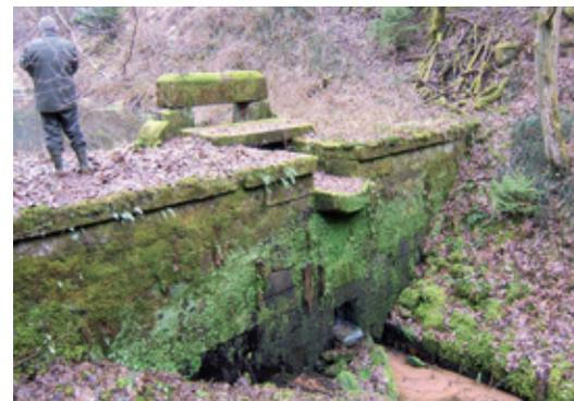
Abb. 9 : Triftklausen mit Grundablass und Überlauf (Ungerthaler Klausen an einem kleinen Seitenbach des Leinbachs).
