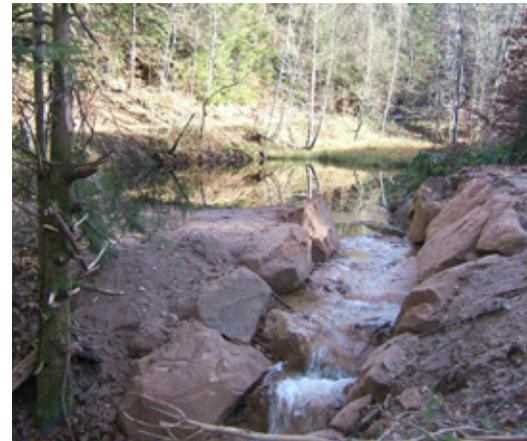
Abb. 8 : Sanierung des Dammes mit neuem, offenem Kaskaden-Überlauf (Kleiner Haseldellweiher an einem kleinen Seitenbach der oberen Moosalbe).
