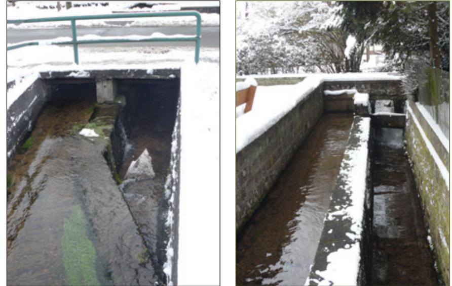
Abb. 5a und 5b: Absturz mit Barrierewirkung im Fischbach direkt neben der Haupttrasse des Ortes Fischbach.
