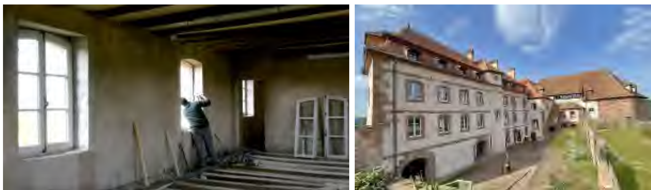
Figure 503 : Pose de menuiseries patrimoniales lors de la rénovation du Château de La Petite-Pierre entre 2017 et 2020 (SYCOPARC)
