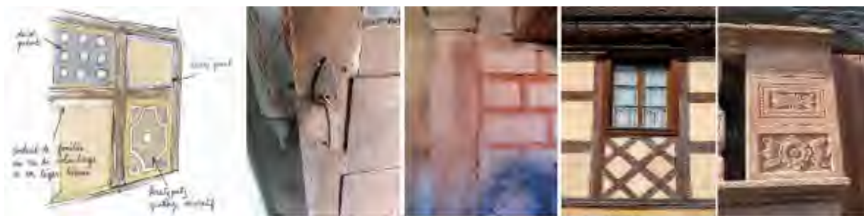
Figure 235 : Les types de décors du pan de bois (D. Schitter) – Clenche de porte (SYCOPARC) – Enduit gaufré (SYCOPARC) – Motifs de treillis et de losanges (C. Hamm) – Décors sculptés (SYCOPARC)
