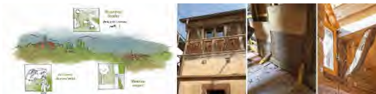
Figure 501 : Schéma économie circulaire locale (D. Schitter) – Remplissage terre/paille allégé (SYCOPARC) – Banchage mélange chaux/chanvre (SYCOPARC) – Isolation panneau fibre de bois - terre /paille allégé et panneau de roseau (C. Hamm)
