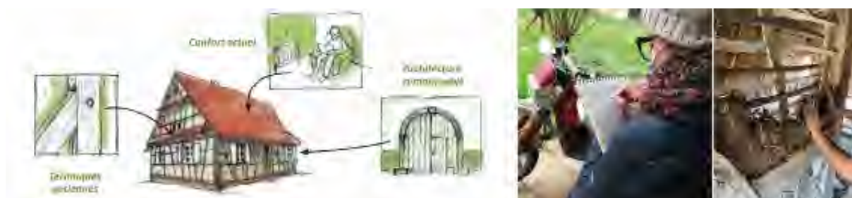
Figure 237 : Schéma état des lieux (D. Schitter) – Diagnostic patrimonial (SYCOPARC) – Mise en œuvre du torchis (SYCOPARC)
