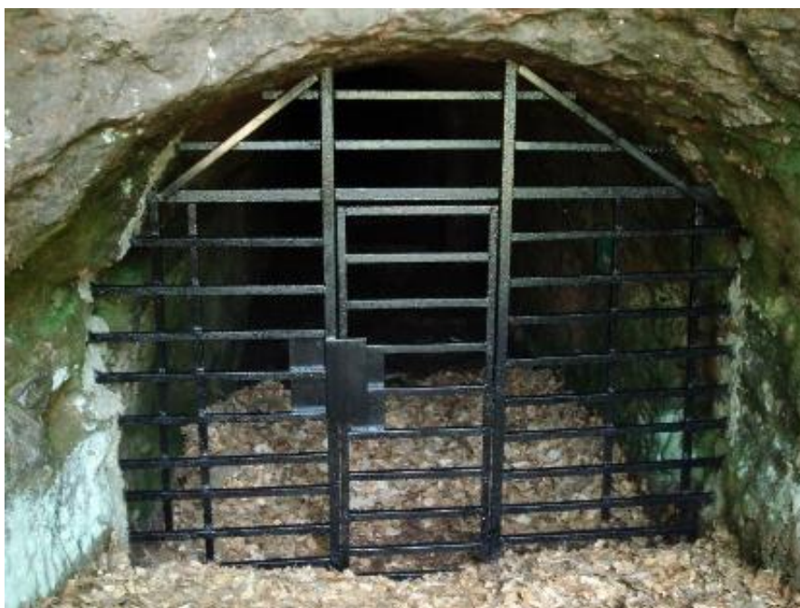
Figure 171 : Grille protégeant l'entrée du souterrain du Ramstein à Baerenthal (57) dans la Réserve Naturelle Nationale des rochers et tourbières du Pays de Bitche (Photo : L. DUCHAMP)
