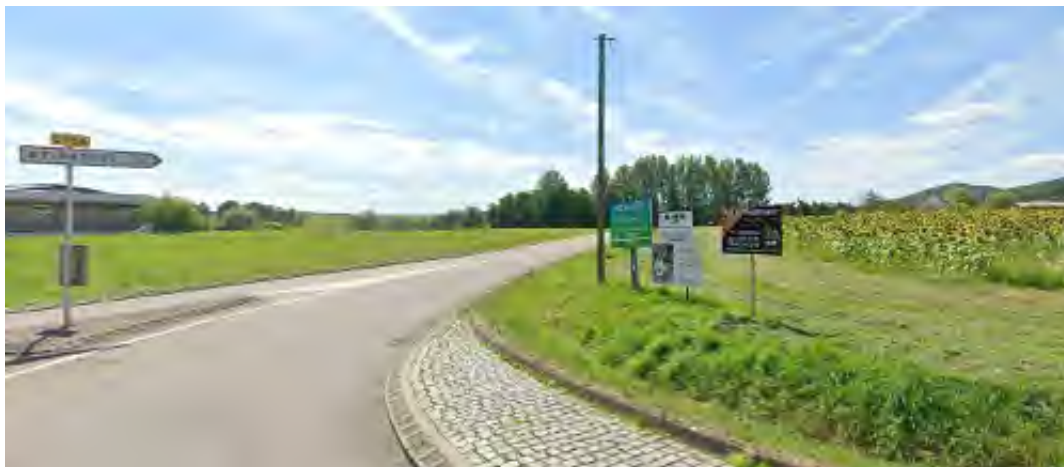
Figure 61 : Panneau de préenseigne vétuste à proximité d'un site touristique majeur du territoire - Route d'Ingwiller entre Wimmenau et Lichtenberg (67)
