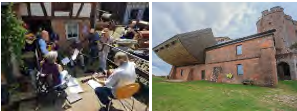
Figure 251 : Maison rurale de l'Outre-Forêt à Kutzenhausen (Communauté de communes Sauer-Pechelbronn) et Château de Lichtenberg (SYCOPARC)
