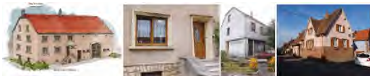
Figure 231 : Organisation maison de la reconstruction (D. Schitter) – Encadrements d'ouvertures à Epping – Vitrine de commerce à Ormersviller – Maison de reconstruction à Lichtenberg ( SYCOPARC)
