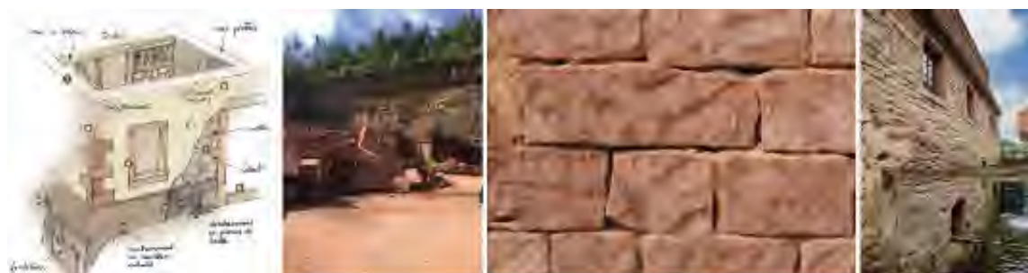
Figure 232 : Système constructif maison pierre (D.Schitter) – Carrière Loegel à Rothbach (SYCOPARC) – Mur maçonné en moellons de grès (SYCOPARC) – Façade en maçonnerie de pierre à Soucht (C Hamm)
