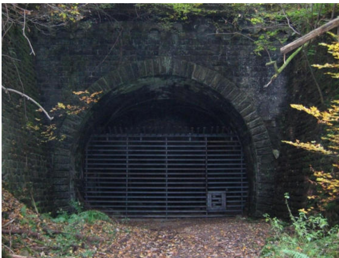
Fermeture du tunnel de Rosteig et Soucht par une grille
