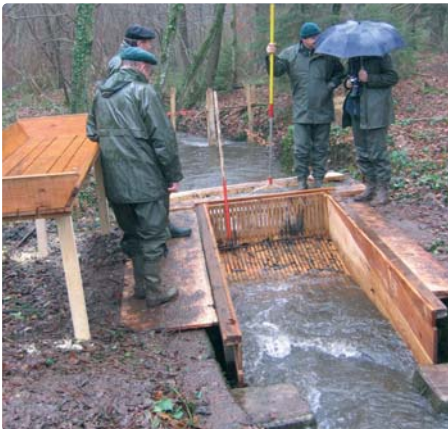
Exemple de pêcherie aménagée en sortie de moine pour permettre la récupération des poissons
