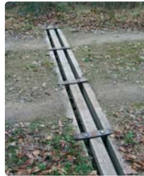
Rigole de dispersion des écoulements sur chemin cammionable afin de limiter l'érosion
