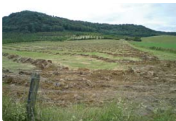
Pose de drains agricoles en zone humide*
