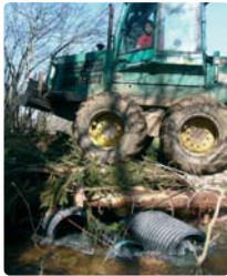
Dispositif temporaire de franchissement en tube PEHD
