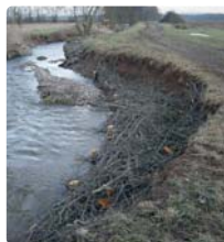
Stabilisation par un « peigne » d'une berge subissant une forte érosion.
