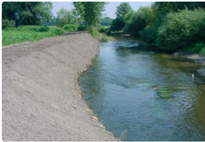
Stabilisation des berges par fascinage : technique végétale douce alliant pieux en bois, fagots et fibre de coco tissée - Service rivière - CG67
