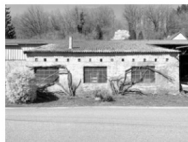
Façade en parpaing existante
