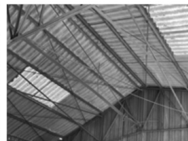
Charpente métallique existante
