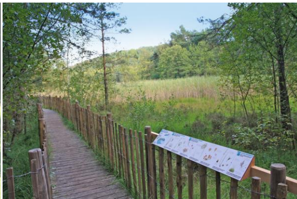
Réhabilitation du sentier de découverte à l'étang de Hanau
