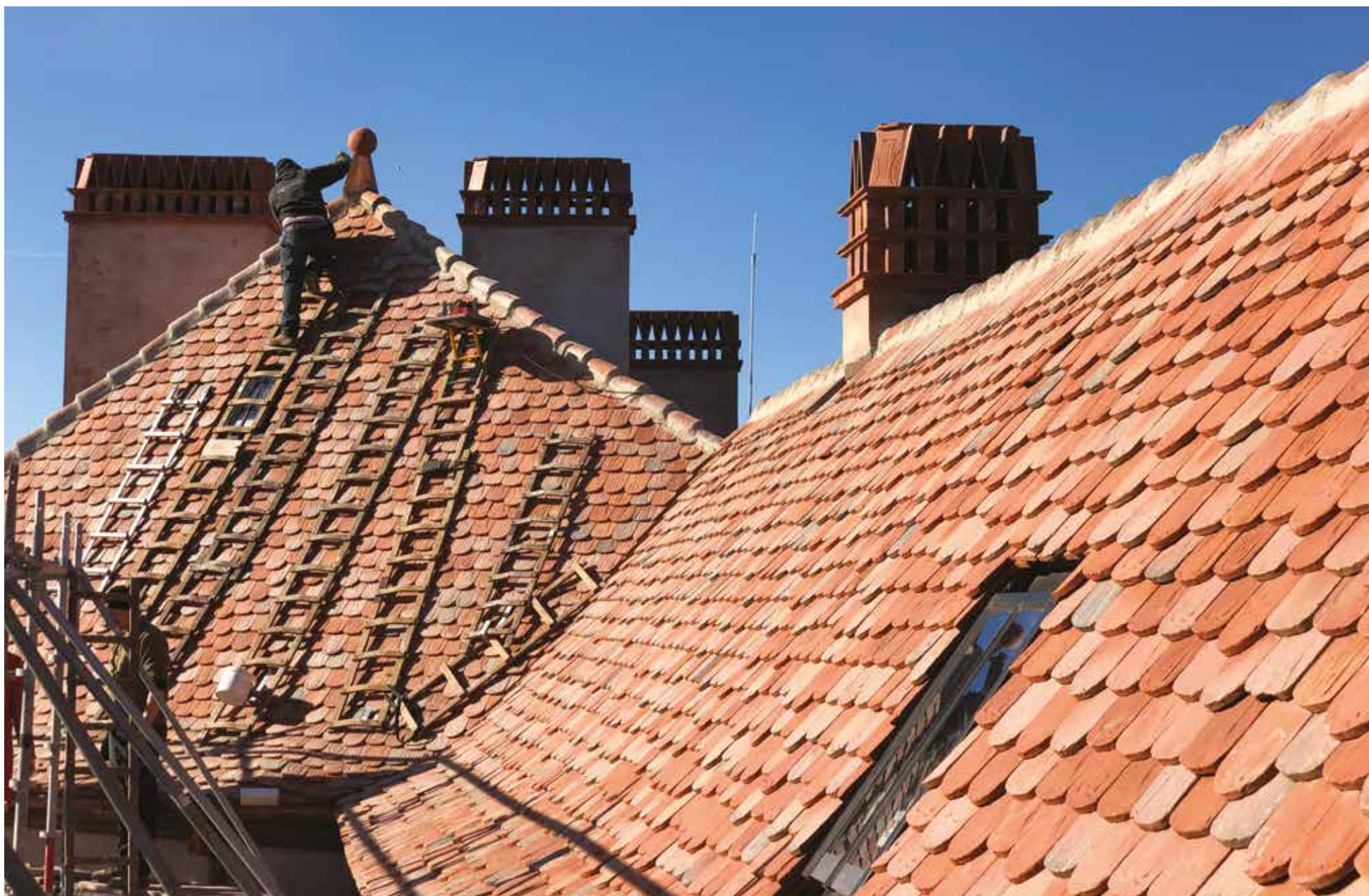
Grâce à une échelle de toit, le couvreur pose un épi de faîtage.
