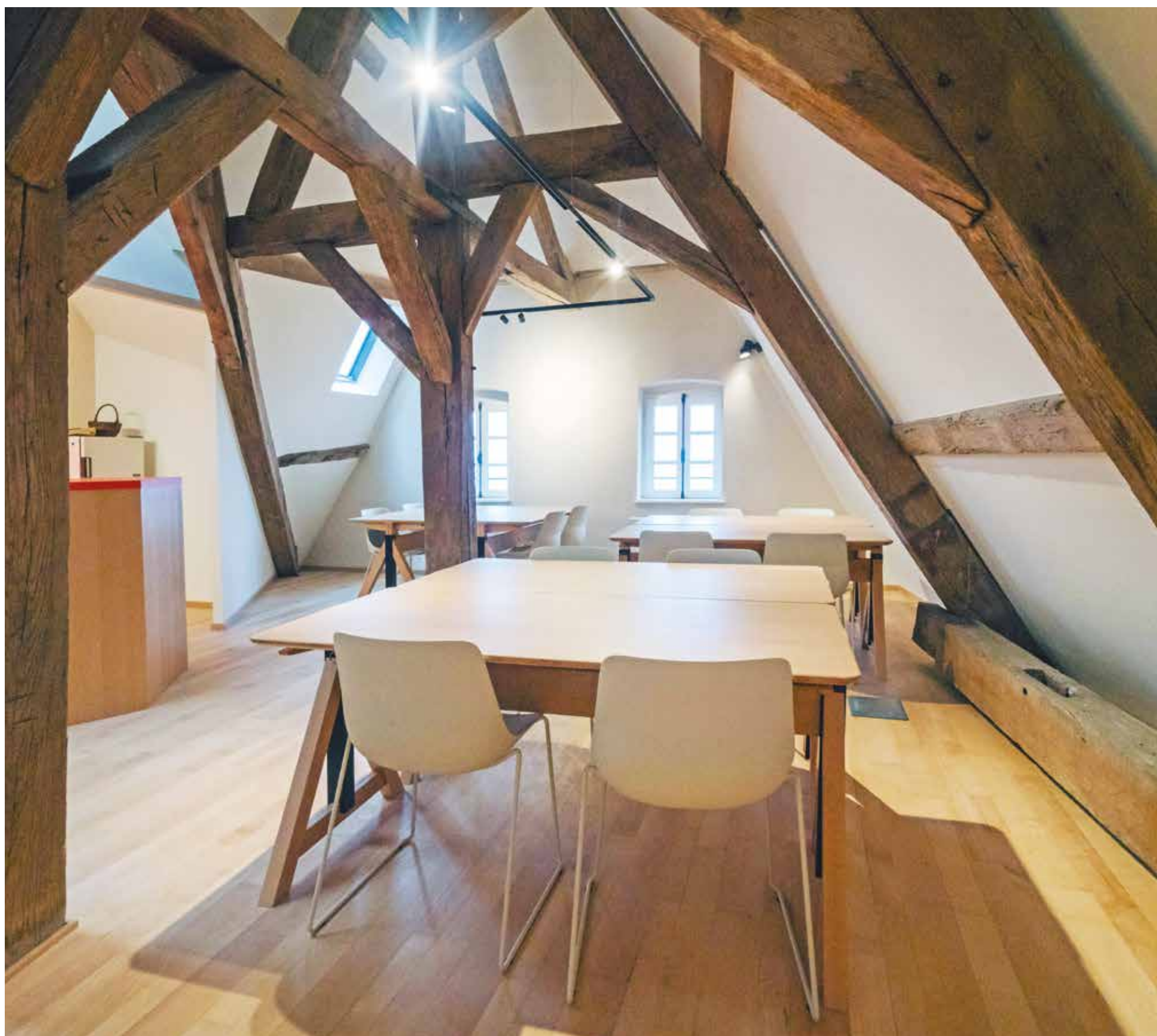
La charpente a été stabilisée en conservant les bois anciens.
