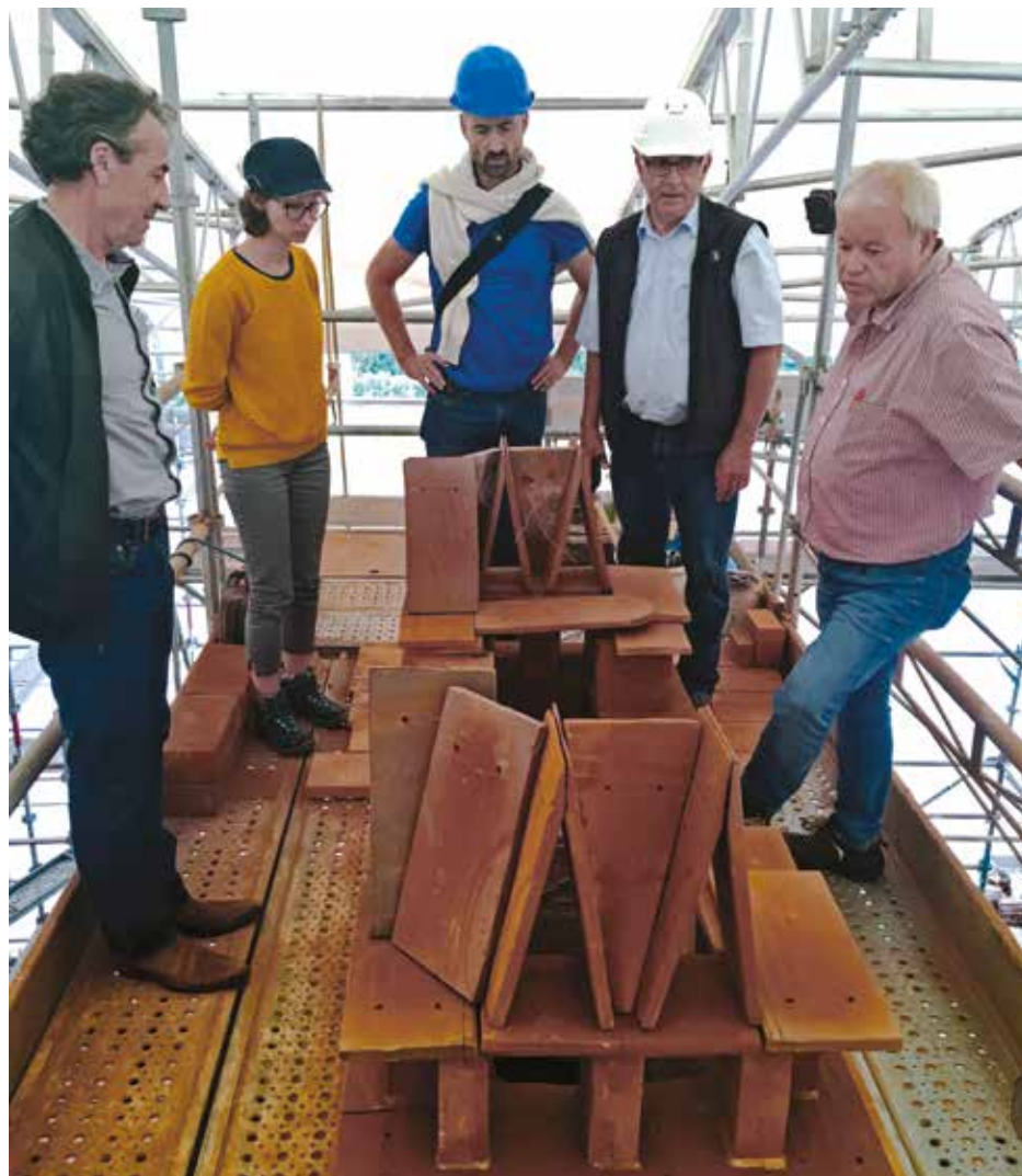
Concertation de l'équipe de chantier sur le toit du château.
