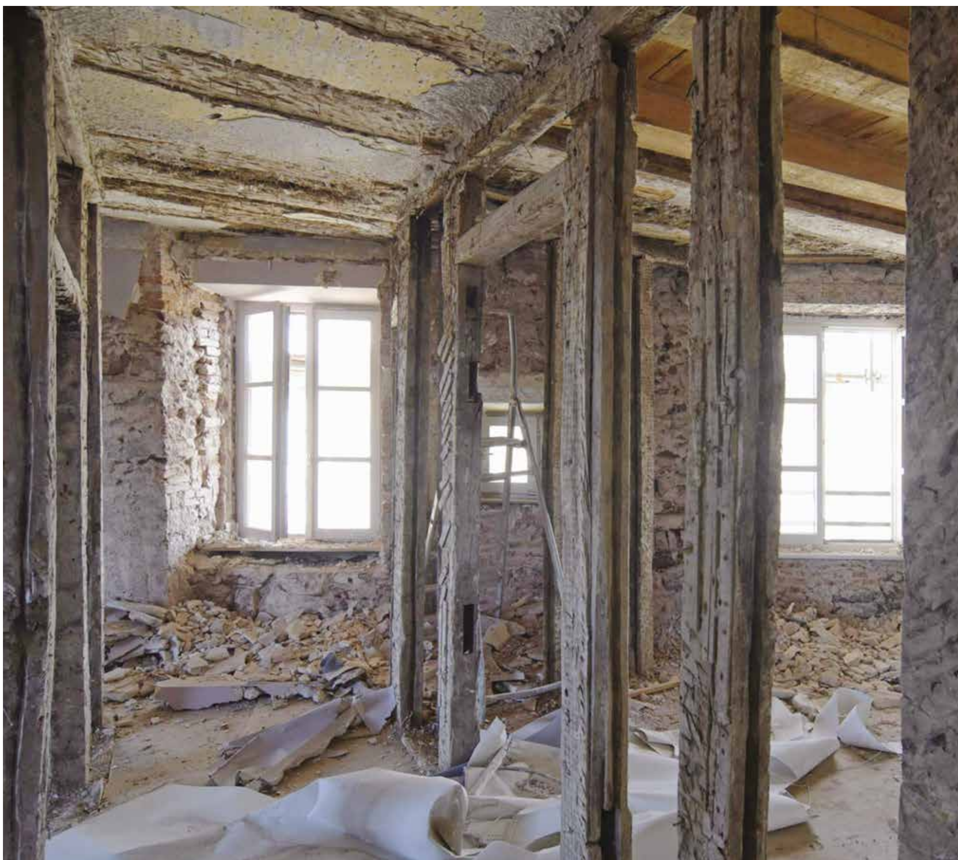
Les cloisons à pan de bois sont évidées.
