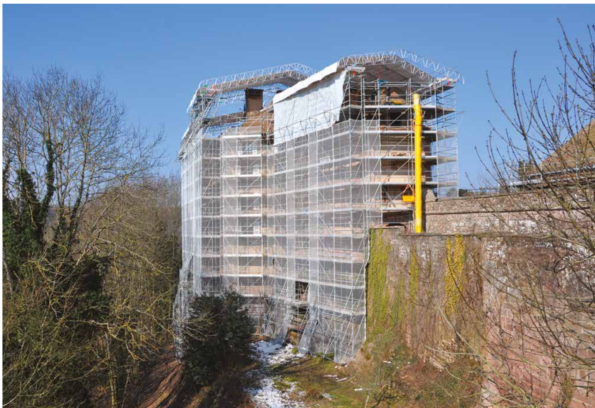
10 niveaux de plateformes sont nécessaires pour permettre aux artisans d'intervenir sur l'ensemble du bâtiment.
