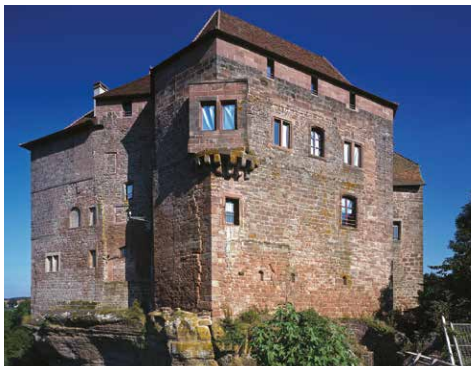
Diversité et superposition des couches historiques du site par la multiplicité des maçonneries successives (extrémité occidentale).
