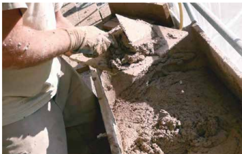
Réalisation d'un mortier de chaux sur le chantier du château.
