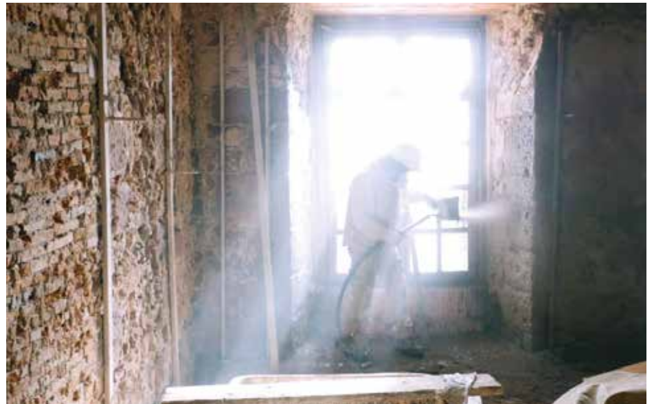
Un ouvrier applique l'enduit correctif à l'aide d'une lance.
