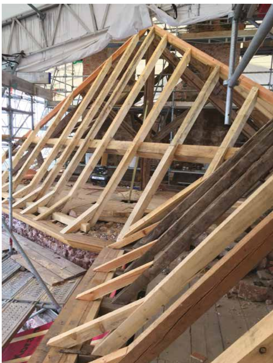
Les éléments de charpente dégradés sont remplacés par de nouvelles sections de bois massif.
