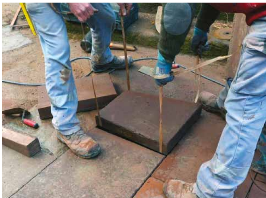
Pose d'une dalle en grès neuve dans la cour du château.
