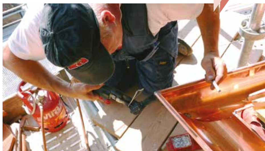
Travail d'un soudeur sur le chantier du château.
