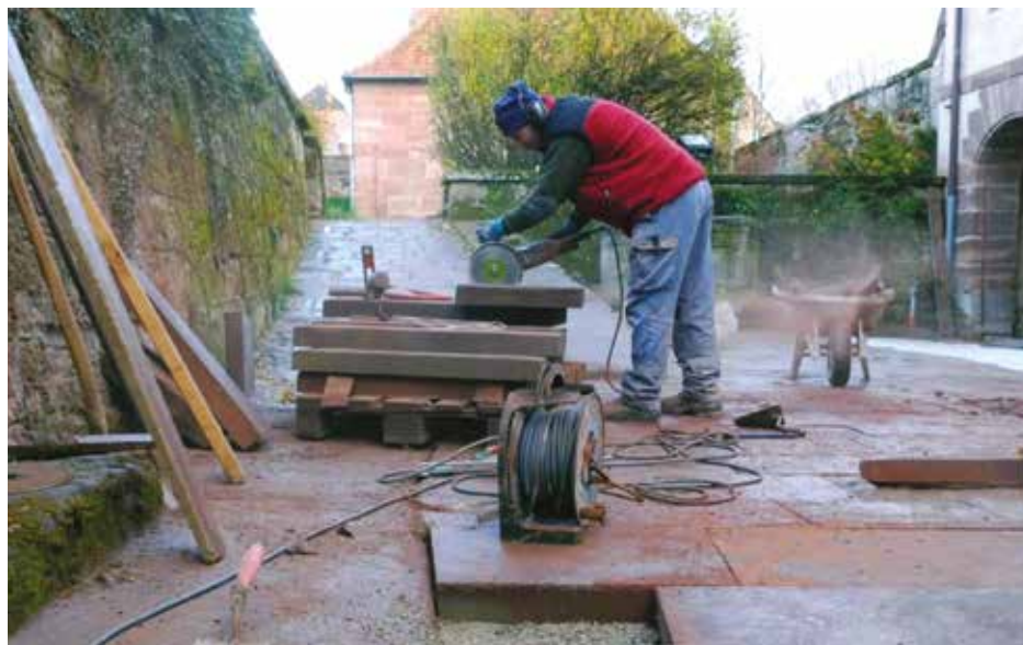
Ouvrier découpant des dalles de grès.
