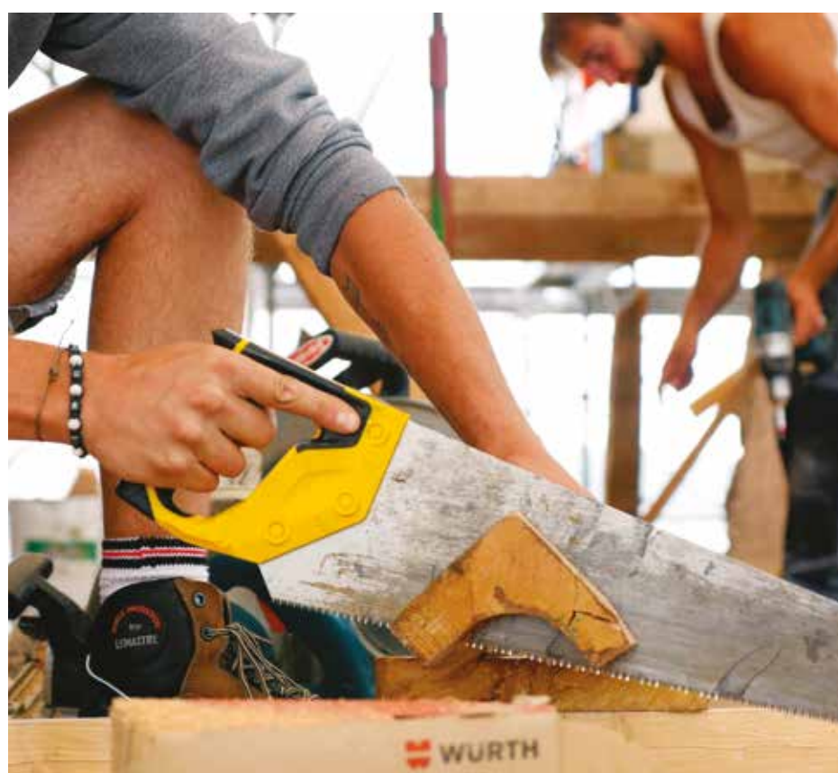
Les menuisiers à l'œuvre.
