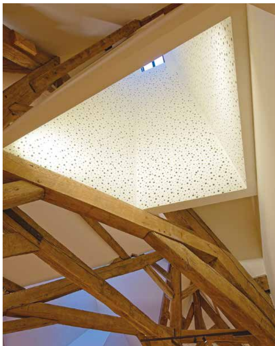
Puits de lumière au 5e étage du château.
