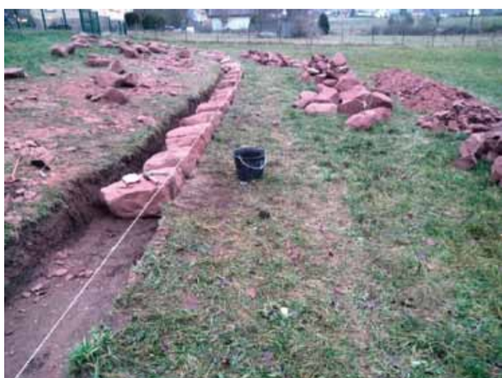
Mur en pierre sèche en chantier Trockenmauer im Bau
