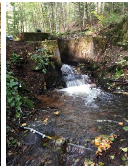
Figure 4 : Antenne 2 (aval) placée dans le Rothenbach en aval de la buse
